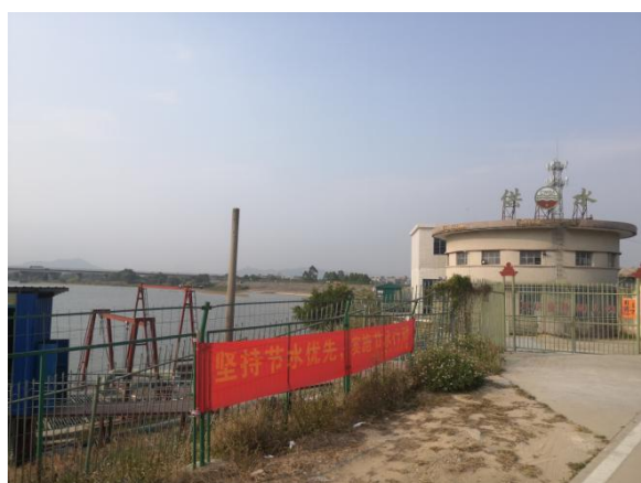
螺河望洋水厂取水口
