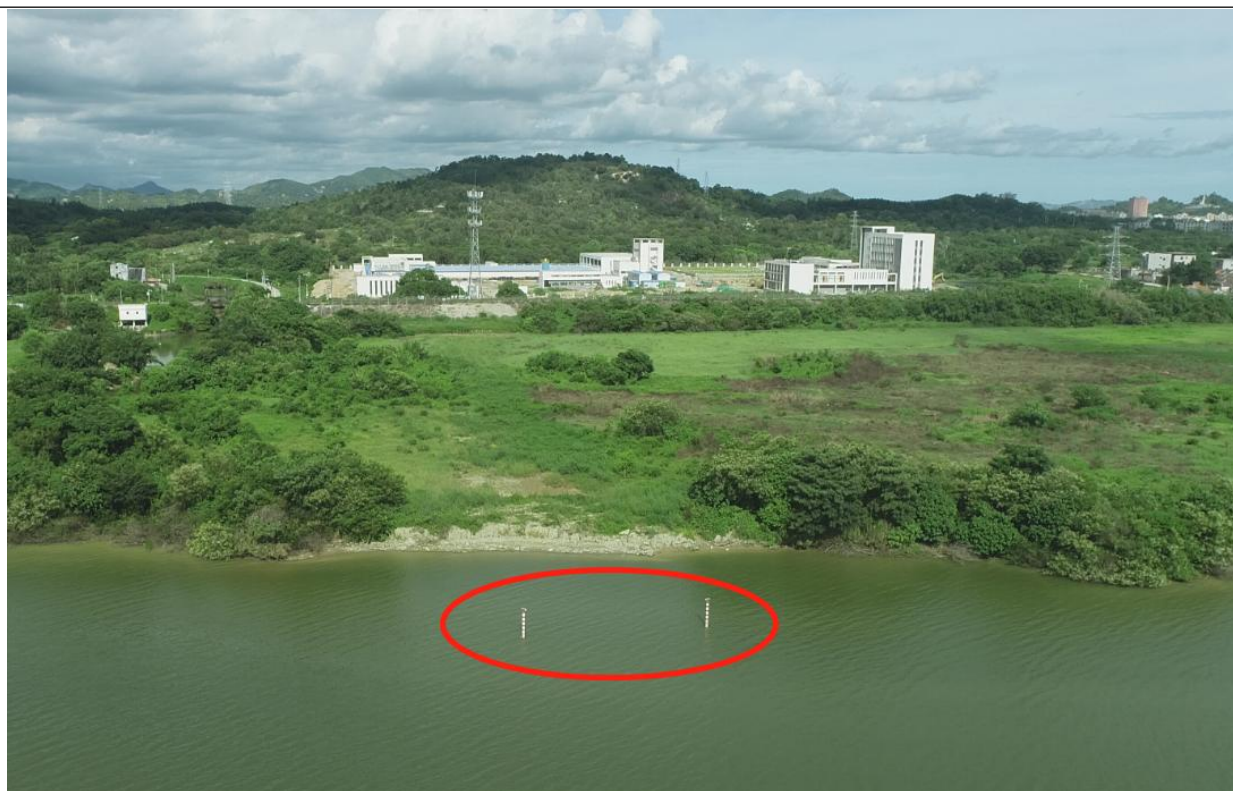
新建取水口航拍照片
