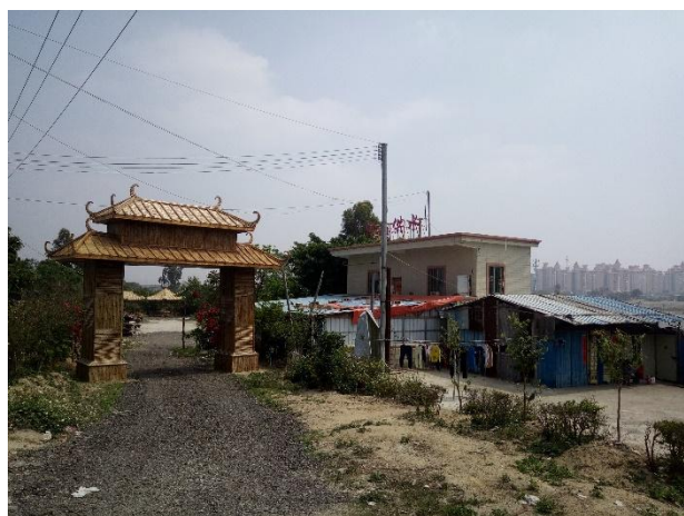
螺河陆丰段河西水厂
