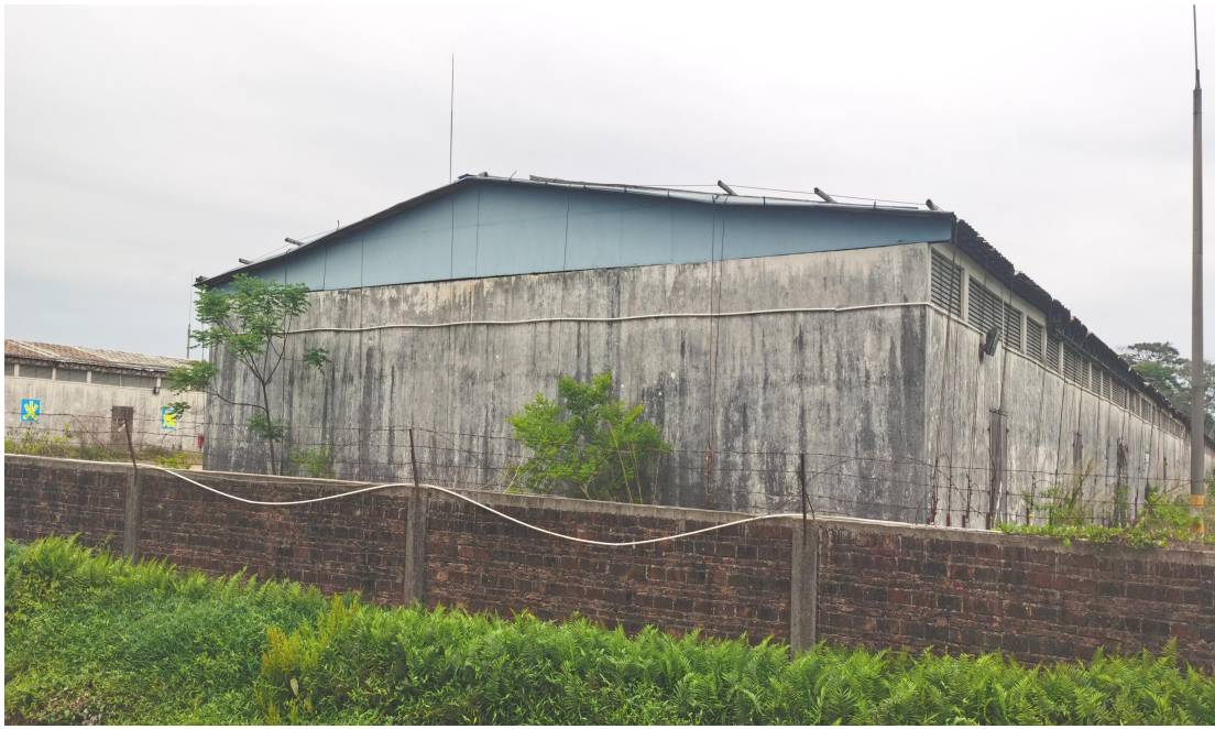
项目北面-空置厂房
